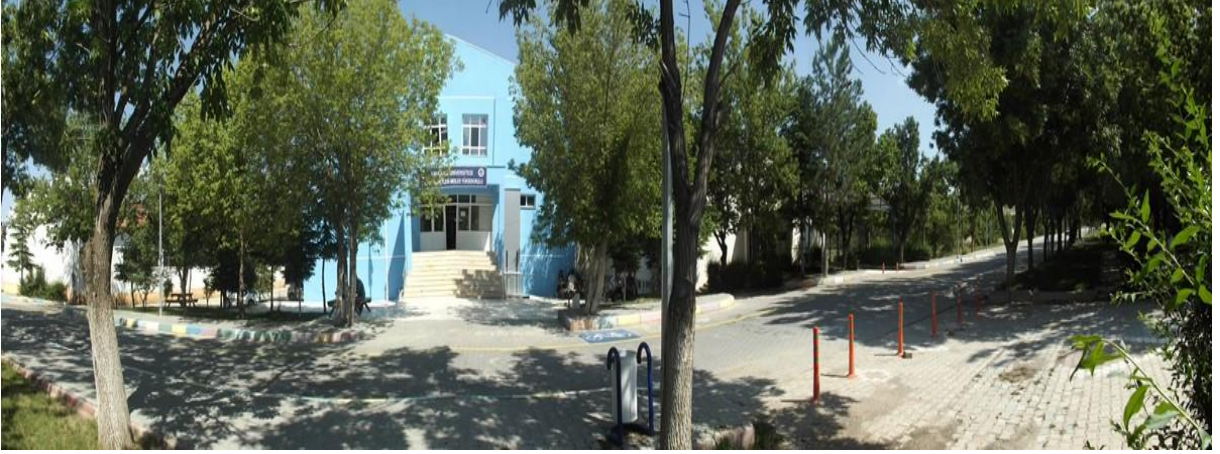
Resim 1 Meslek Yüksekokulu Hizmet Binası
